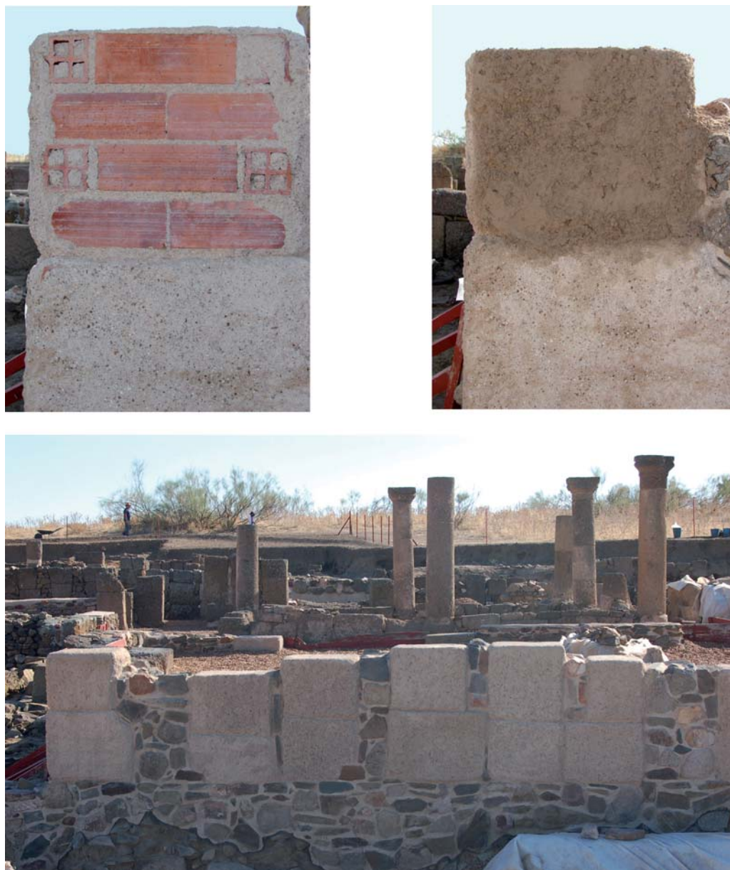
Figura 8. Restitución de sillares en el yacimiento de La Bienvenida (Ciudad Real) como medio de protección de la fábrica muraria y como sistema de restitución volumétrica para un mejor entendimiento de las estructuras. (Foto: G. Esteban.)
