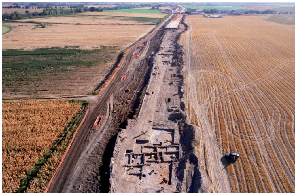
Figura 4. Excavación de un yacimiento romano en el curso de las obras del Ave Madrid-Toledo. (Foto: J. M. Rojas et alii . 2004.)
